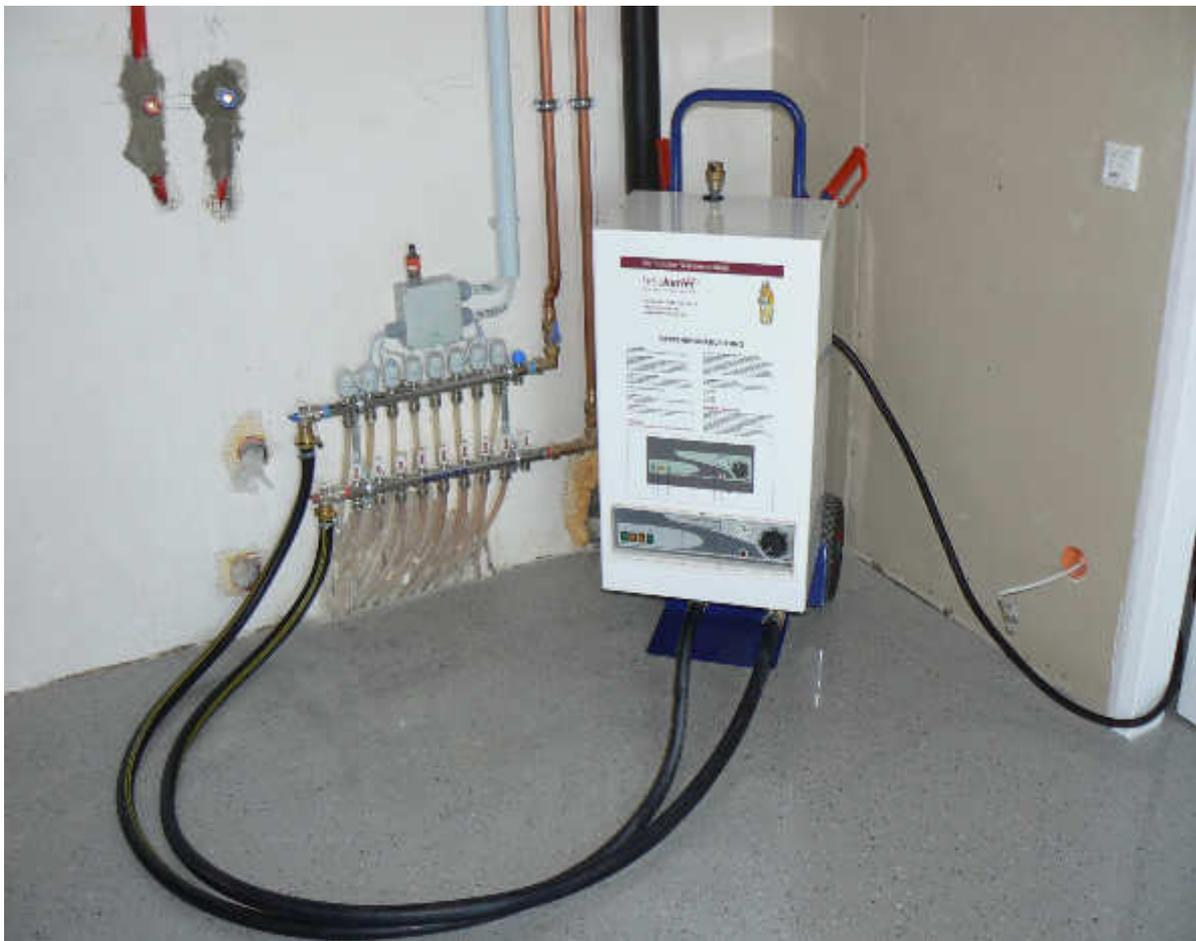
**Die mobilen Heizgeräte werden direkt an den Verteiler der Fußbodenheizung angeschlossen.**
